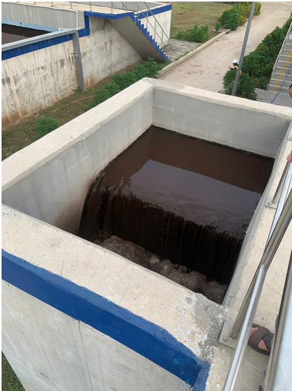
Bể đầu ra mương OD
